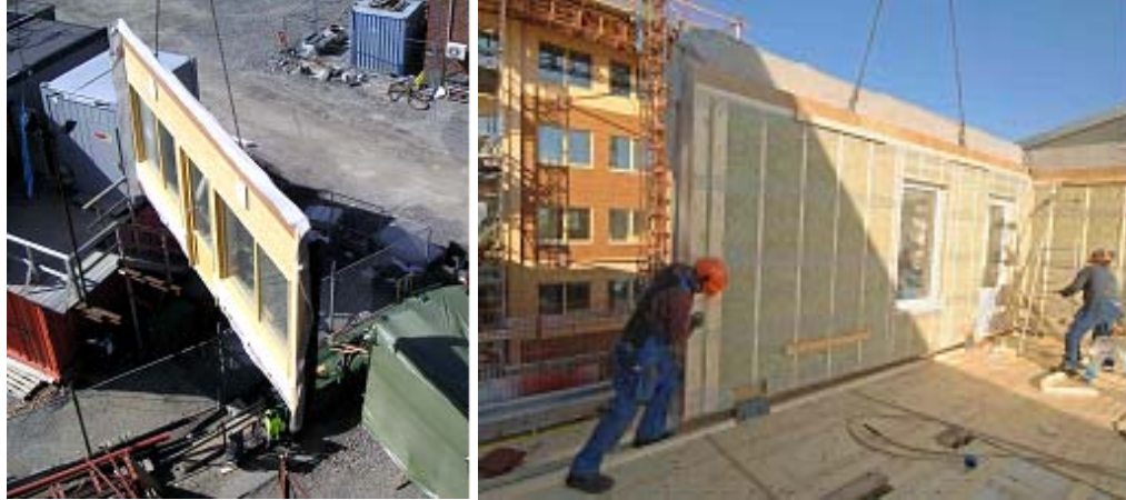
Figur 32. Montage av ytterväggselement
