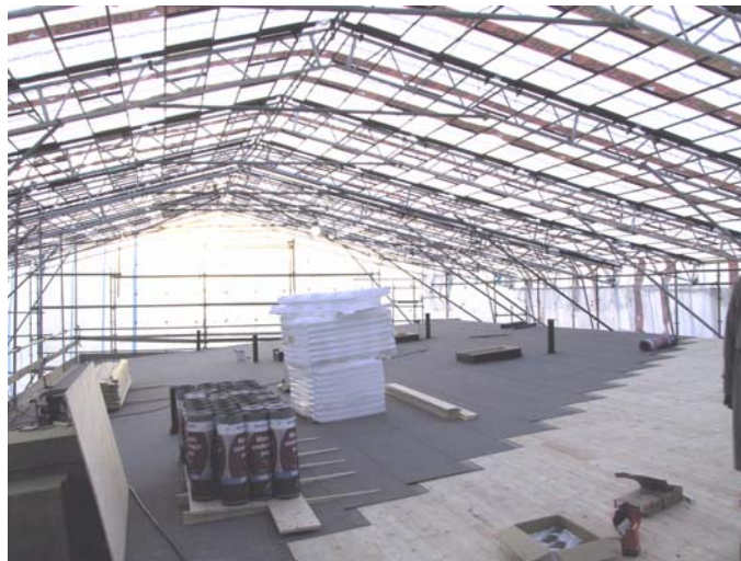
Figur 3. Interiör från nybyggnadsprojekt med fast takväderskydd.
