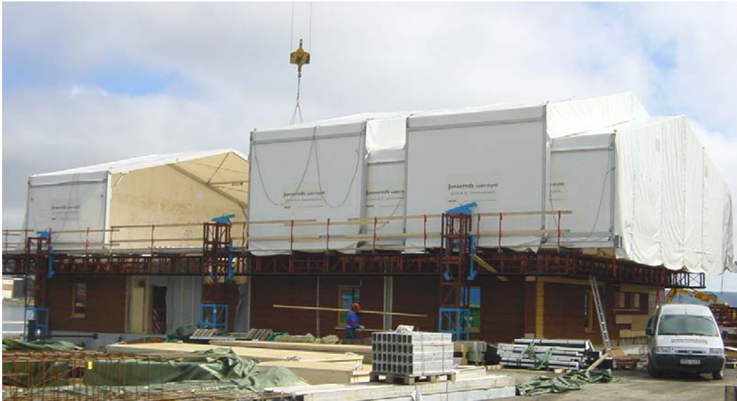
Figur 6. Hallbyggarna Jonsereds system Gibson Tower vid nyproduktion av bostäder i Sundsvall
