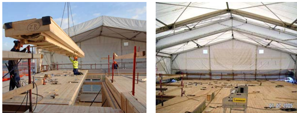
Figur 34. Montage av kasettbjälklag
