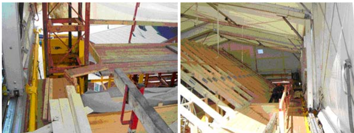
Figur 35. Några problem som upplevdes negativa Till vänster: Passage som är krånglig inte bara när det blåser Till höger: Plankplattformen upplevs som trång
