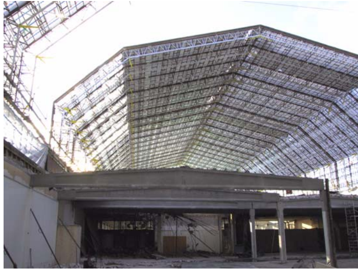
Figur 5. Karlstads universitet. Mobilt takväderskydd vid större om- och tillbyggnad. Spännvidd 33m.
