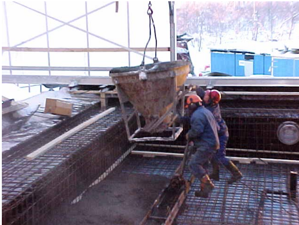
Figur 4. Äventyrsbad i Kiruna. Gjutning av betong i januari månad under mobilt takväderskydd klätt med isolerade plastpaneler.
