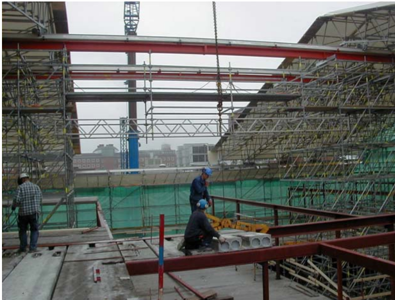
Figur 18. Öppning av takväderskyddet vid inlyftning av håldäcksbjälklag
