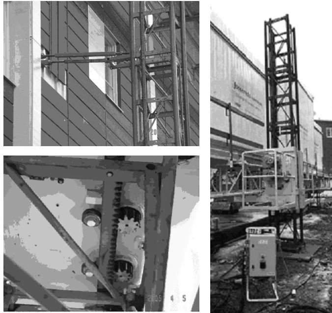
Figur 31. Väderskyddet – några detaljer Uppe till vänster: Förankring av torn i byggnaden Nere till vänster: Kuggstångsdrivning Till höger: Plattform som lyfts av motor på kuggstångsförsedd mast
