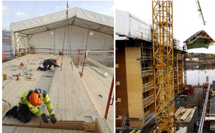
Figur 29. Två foton från användningen av väderskyddet Till vänster: Takväderskyddet är öppnat för inlyft av element Till höger: Yttertaket byggs på marken och lyfts upp i delar
