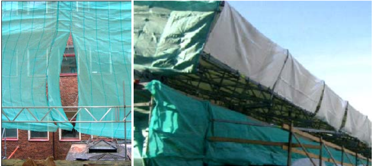
Figur 21. Till vänster: Offshoredukarna har blåst isär. Av säkerhetsskäl skall buntbanden brista då vinden hastigheten blir för stor. Till höger: Glipan genom vilken snö kunde blåsa in
