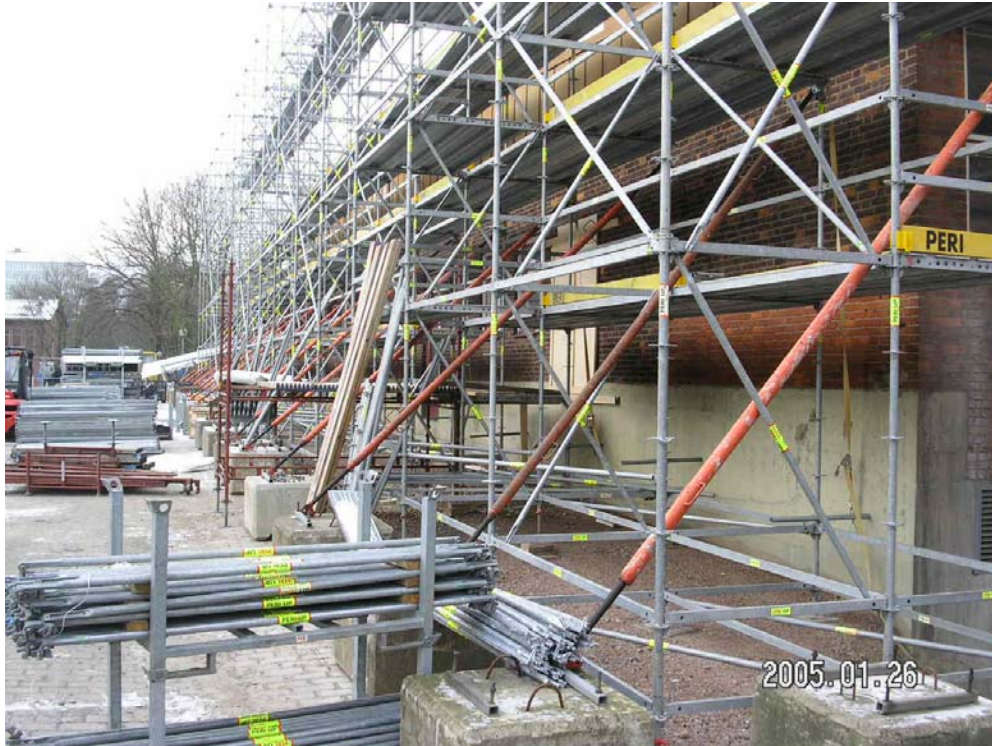
Figur 17. Fasadställning
